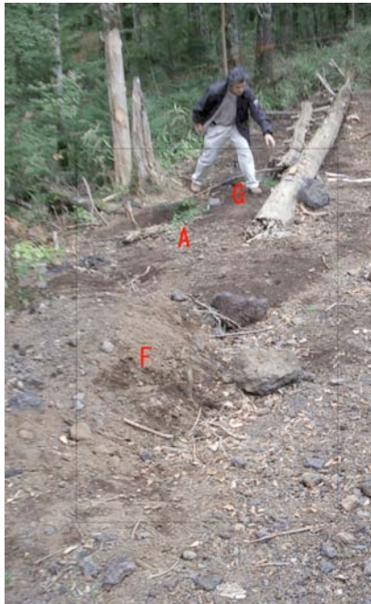
図2 地点1の陥没にともなってできた地溝の北縁部。A, G, Fは9月19日の日大調査による地点名。10月5日時点での写真（左上）とその熱映像（右上）、ならびに10月23日時点での写真（左下）とその熱映像（右下）。
